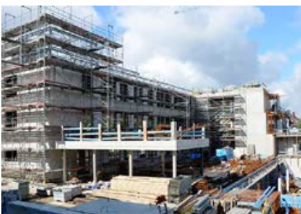
Der Bauboom sorgt für Wirtschaftswachstum.
