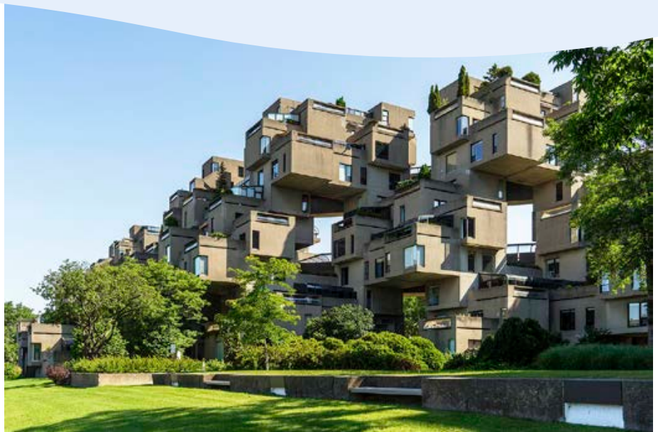
„Habitat“. Weltausstellung Montreal 1967 Einer der ersten Bauten des modernen Strukturalismus. Eine Ordnung finden, die nachträgliche Veränderungen erlaubt. Allerdings extrem energieungünstig wegen des viel zu hohen Außenwandanteils.
