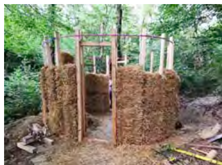
Die Rotunde wird mit Strohballen ausgekleidet.
