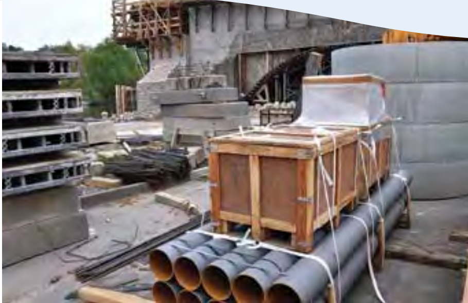
Immer wieder wird aufgedeckt, dass auf dem Bau Dumpinglöhne ausgezahlt werden. Mit Nachhaltigkeit hat das nichts zu tun. – Foto: © Pat Christ
