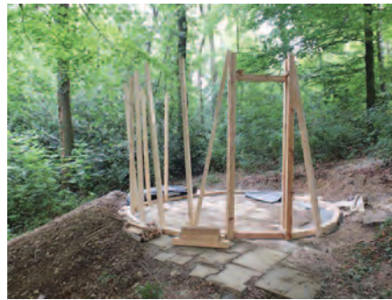
Das Gerüst der Rotunde entsteht.
